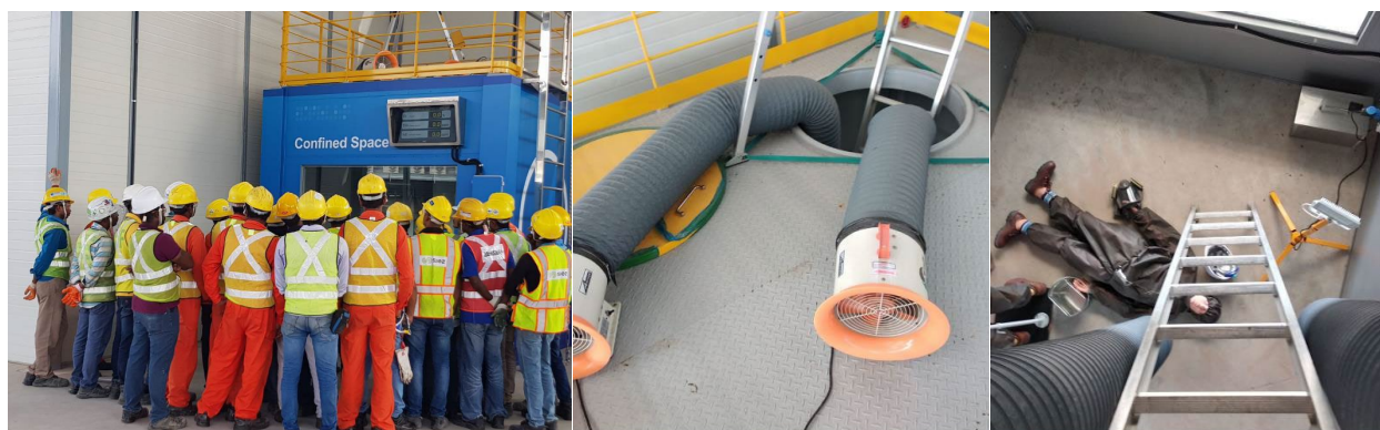
図2 閉鎖空間での作業
