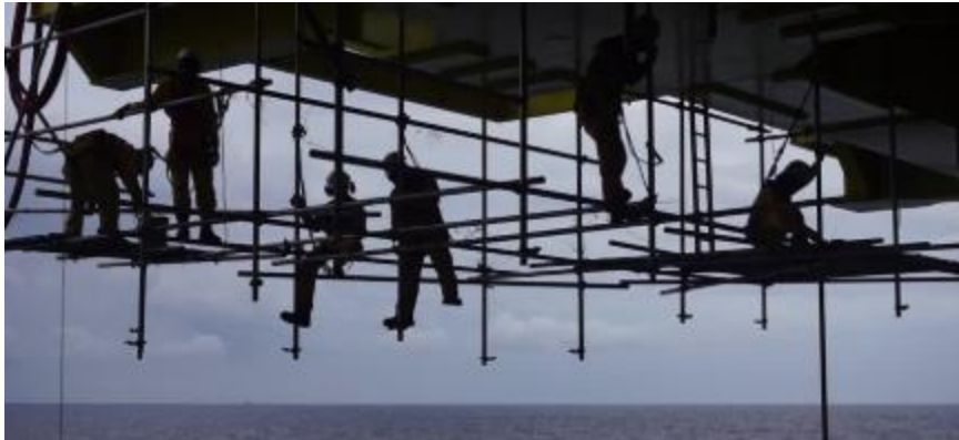
图31 悬挂式脚手架
