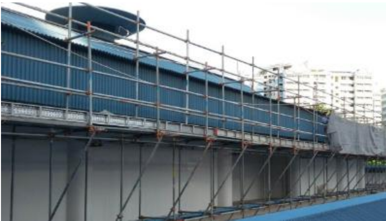
图32 悬臂式脚手架
