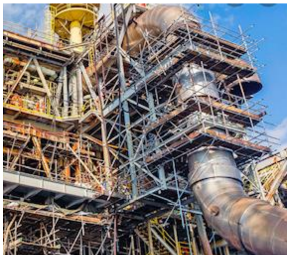
图33 扣件式管道脚手架
