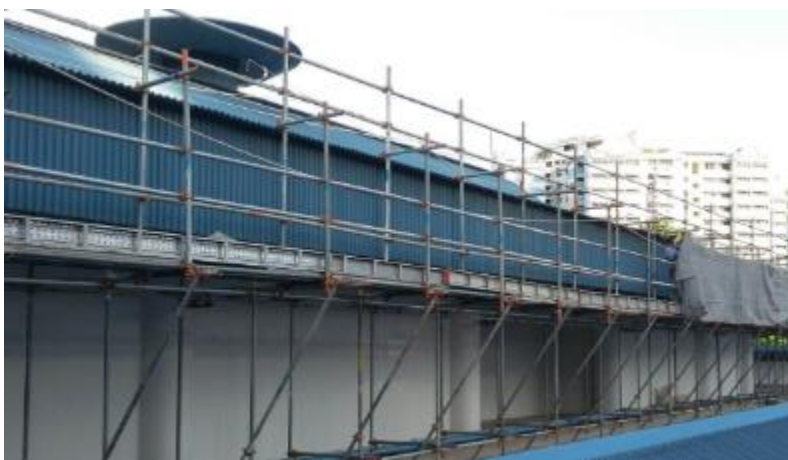
圖 32 懸挑式腳手架
